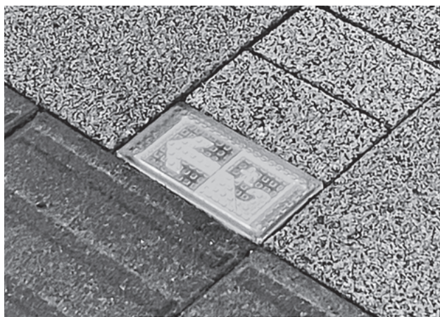
【挿図6】 道路沿いに設置された反射板、蓄光式避難誘導標識の一例
